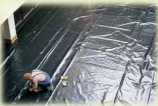
Folie WSF 40 chroniące przed przerostem korzeni dostarczane są w formie wielkoformatowych powłok.
