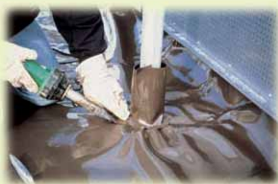
Folie WSB 80-PO chroniące przed przerostem korzeni należy zgrzać gorącym powietrzem.
